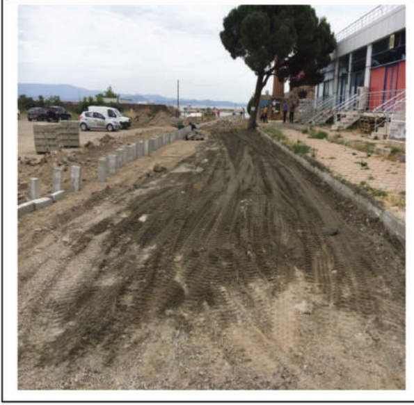
Güre mahallesi kordon yürüyüş yolu bağlantı sokaklarda yapılan granit küp taş döşeme faaliyeti.
