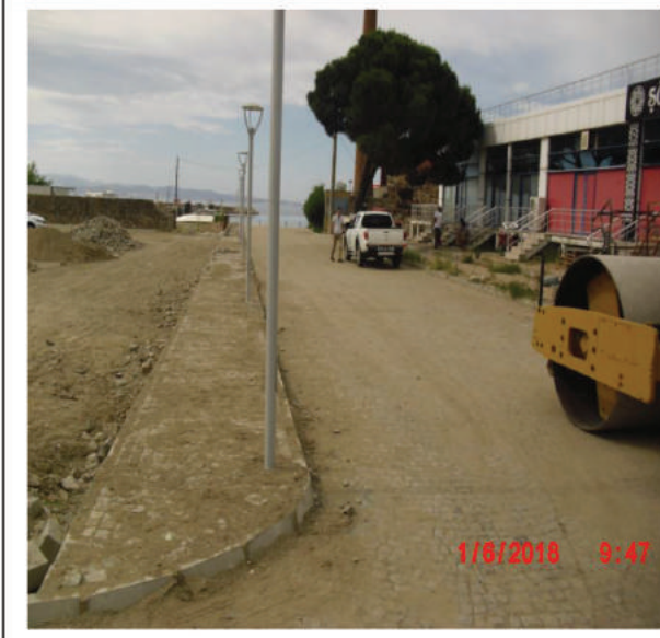
Güre mahallesi kordon yürüyüş yolu bağlantı sokaklarda yapılan granit küp taş döşeme faaliyeti.
