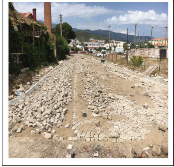
Güre mahallesi kordon yürüyüş yolu bağlantı sokaklarda yapılan granit küp taş döşeme faaliyeti.
