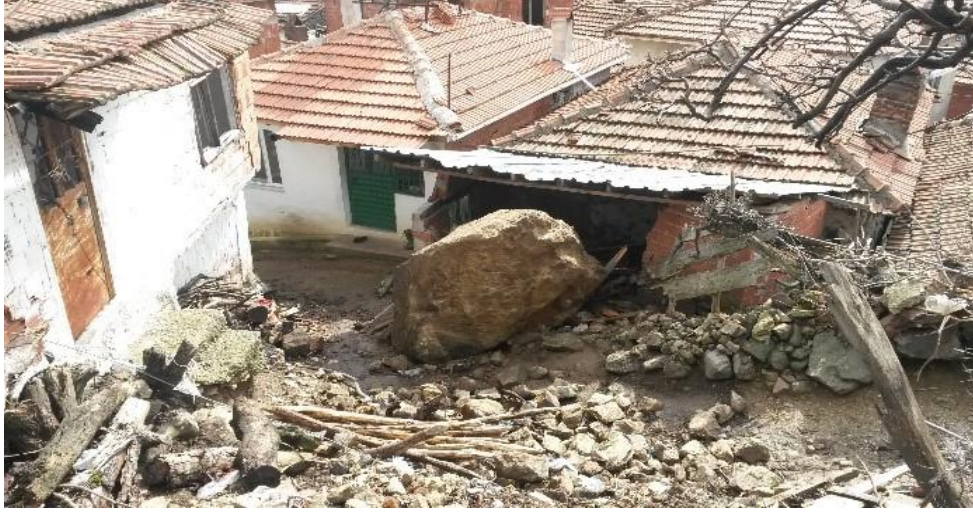
Resim 1.13. Havran İlçesi Çakmak Mahallesi'nde Meydana Gelen Kaya Düşmesi Olayı
