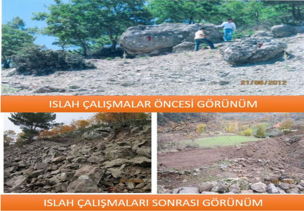
Resim 1.15. İvrindi İlçesi Gebeçınar Mahallesi'nde Yapılan Islah Çalışmaları
