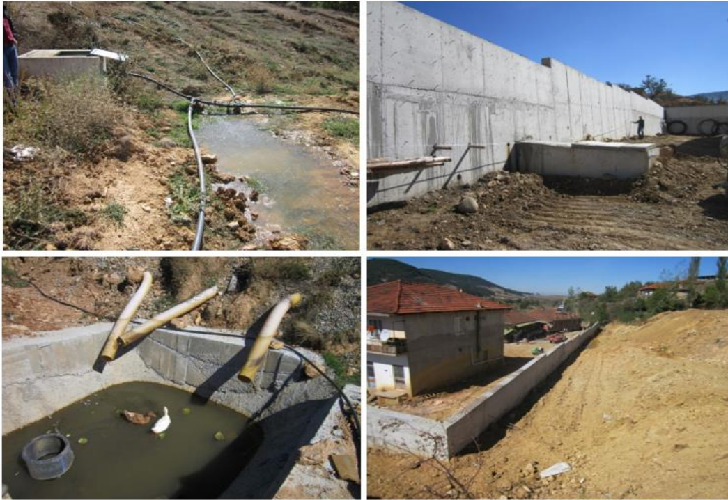
Resim 1.16. Sındırgı İlçesi Yaylabayır Mahallesi'nde Yapılan Islah Çalışmaları
