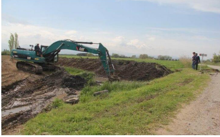
Resim 1.18. Burhaniye İlçesi Karınca Deresi Islah Çalışmaları
